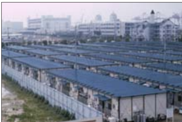
Abb. 1 Notunterkünfte in Kobe nach dem Erdbeben 1995 (Foto: Ronald Kunze)
